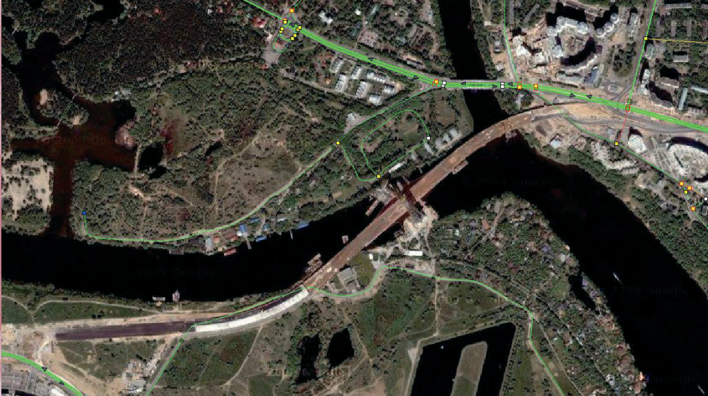
Рис. 4. Участок строительства новой дороги на космическом снимке
